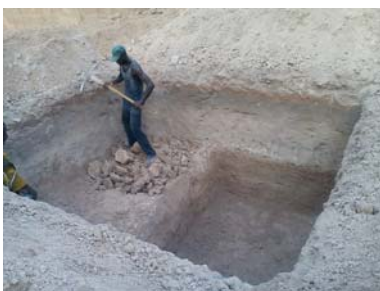
påbörjade Hamadi bygget med de nya toaletterna. Det är ett hårt arbete att hacka sig ner 4 meter. Detta arbete görs av byfolket som lovat att hjälpa till med grävningsarbetet.
