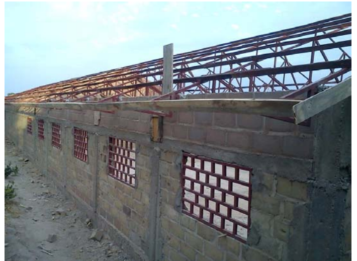
Takstolarna som tillverkades vid kusten och transporterats de 40 milen till Basse har anlänt. Nu var det dags för ett tungt arbete. Som de flesta arbetsmomenten på detta bygge så är det handkraft som gäller då det inte finns maskiner till hjälp.
